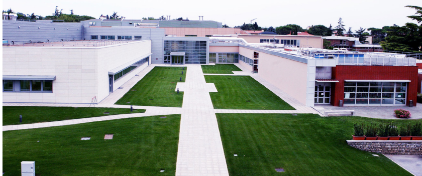
Impermeabilizzazione di tetti di edifici industriali a Castel Guelfo di Bologna
