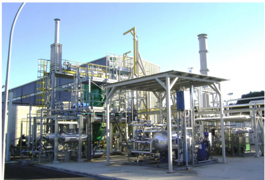
Fig. 2 Infrastruttura di Ricerca Europea ZECOMIX per lo studio del processo di cattura della CO_2 attraverso un processo di carbonatazione
